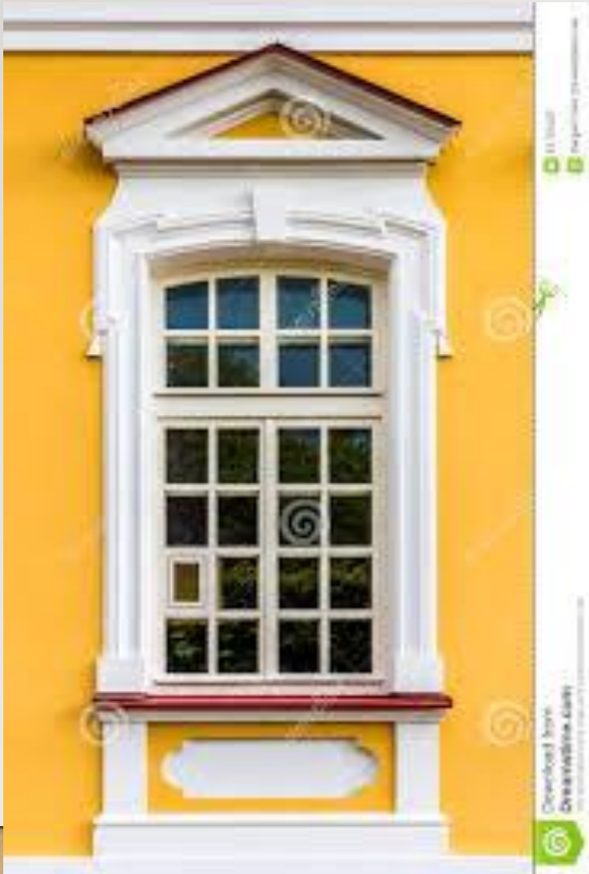
Elementy formy barokowej: a) obramienie okienne z uszakami, b) lukarny, c) naczółki nad otworami okiennymi i drzwiowymi
